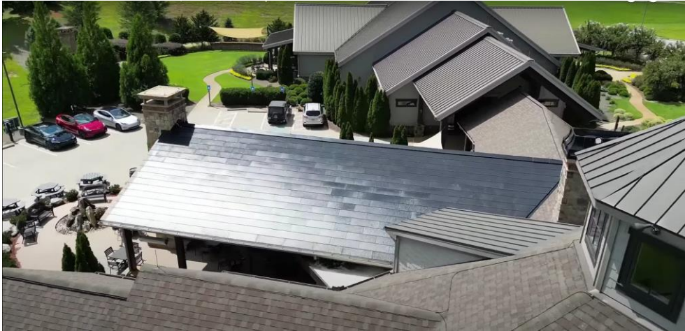
Parte del tejado de una casa con el Solarroof de Tesla.
